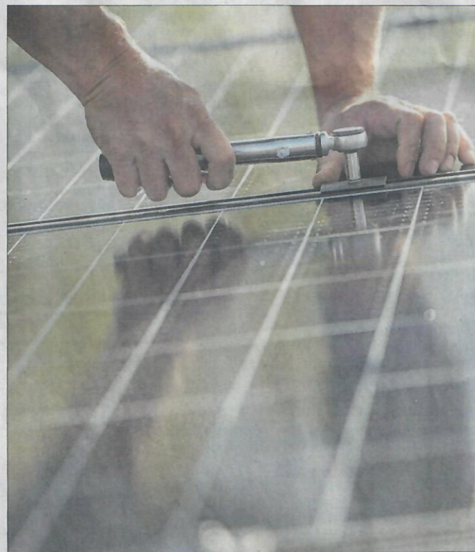
Die 460 Meter breite und fünf Meter hohe Photovoltaikfront soll in etwa den Stromverbrauch von 150 Haushalten abdecken können.
